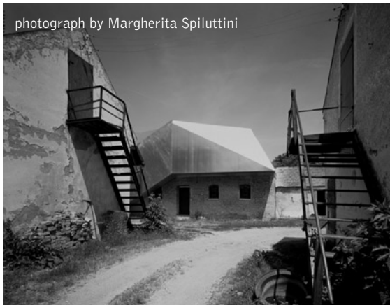
Raum Zita Kern by Artec Architekten
